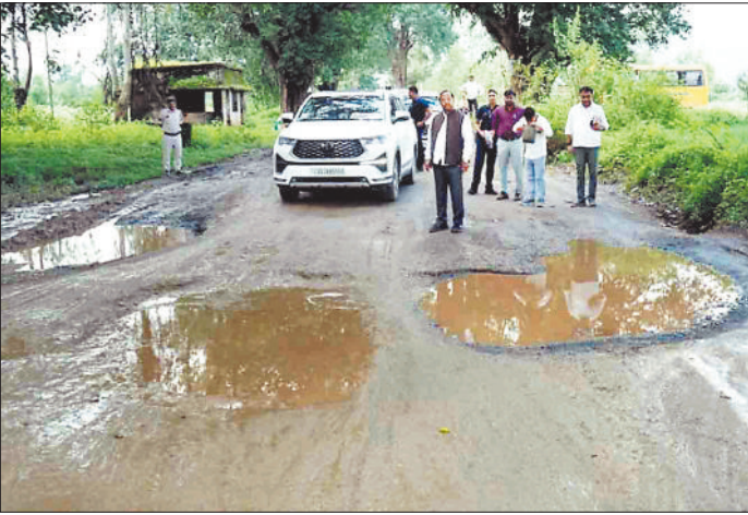
जर्जर सड़क का निरीक्षण करते कैबिनेट मंत्री।
